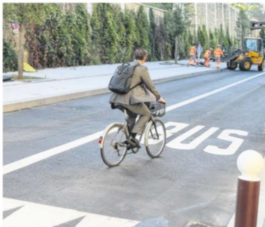
Rue de Tocqueville, les vélos ont normalement une piste cyclable réservée (sur la gauche). Mais elle n'est pas encore matérialisée.
